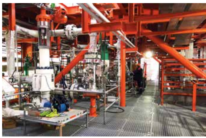
Piattaforma attualmente in costruzione in Kazakistan
