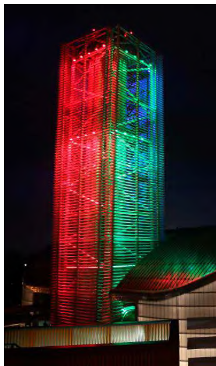
La centrale di cogenerazione Hera di Imola
