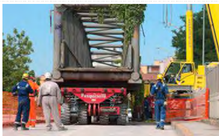
Il cantiere per la costruzione del nuovo ponte
