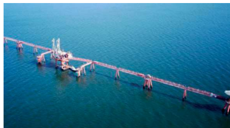
L'infrastruttura sfrutterà gli impianti a mare della Petra
