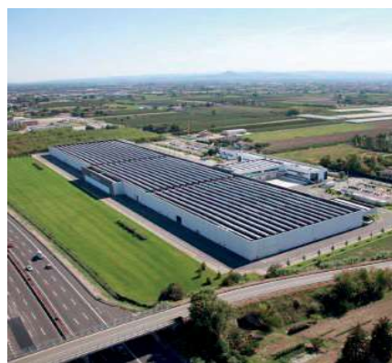
Lo stabilimento Dorelan a Forlì
