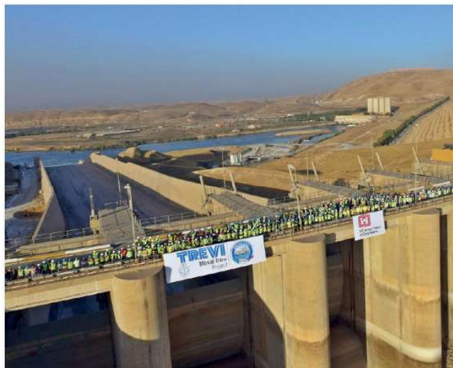
Gli operai Trevi alla diga di Mosul
