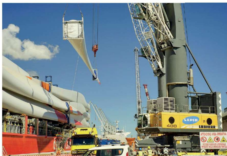
Lo sbarco dell'impianto alla banchina della Sapid
