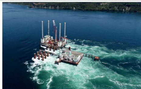
Un cantiere per l'impianto di palificazioni in acqua
