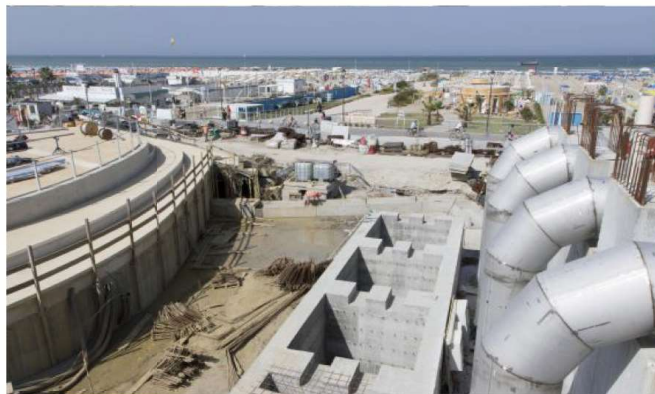
Le condotte del Psbo in piazzale Kennedy quando erano in fase di costruzione
