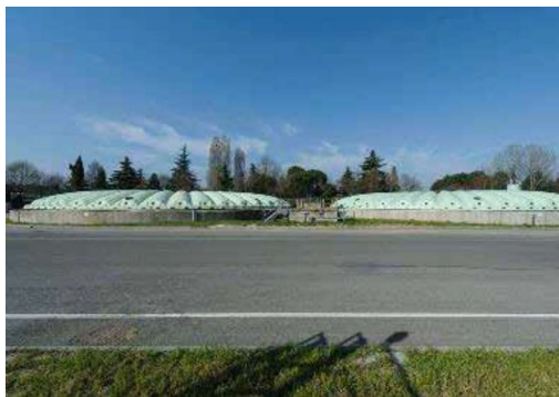
Il prototipo realizzato presso l'impianto di depurazione di Hera e utilizzato in un terreno adiacente
