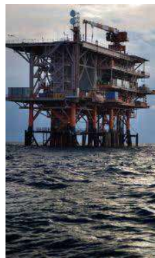
Sopra la centrale di Casalborsetti, sotto una piattaforma in Adriatico
