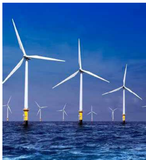
Il progetto Agnes prevede l'installazione al largo delle coste di 75 pale
