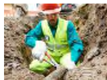
La riparazione di una conduttura
