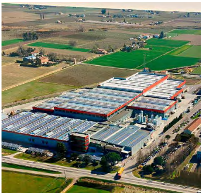
Sul tetto della Madel di Cotignola i pannelli fotovoltaici che garantiscono autonomia energetica all'azienda
