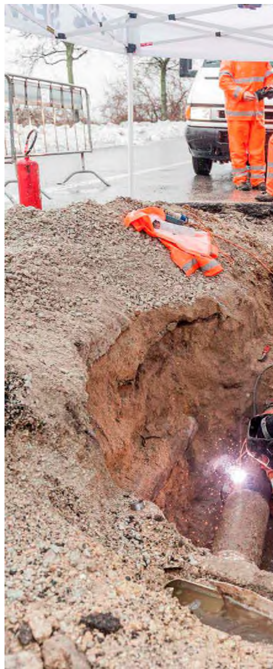
I tecnici delle condotte del gas al lavoro. A sinistra in alto la sede di Sgr
