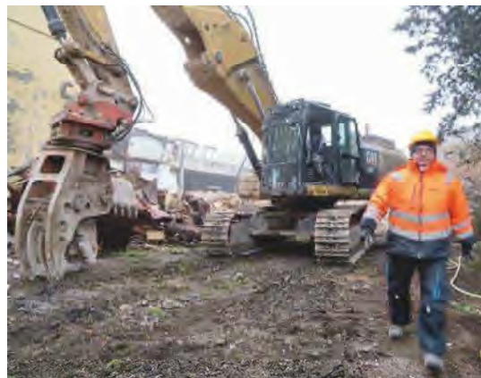
Alcune immagini delle operazioni in corso in via Filanda Nuova
