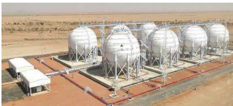
Un impianto di stoccaggio realizzato da Paresa a Karthoum in Africa
