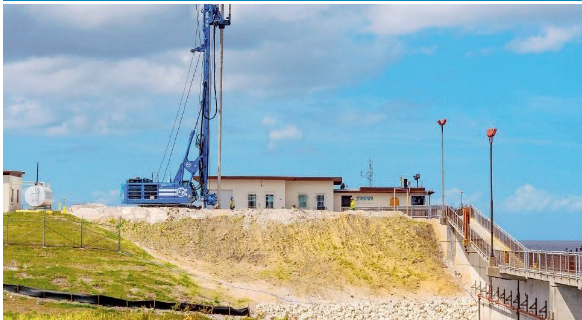
Uno dei giganti meccanici di Trevi all'opera alla diga di Herbert Hoover, nel sud della Florida
