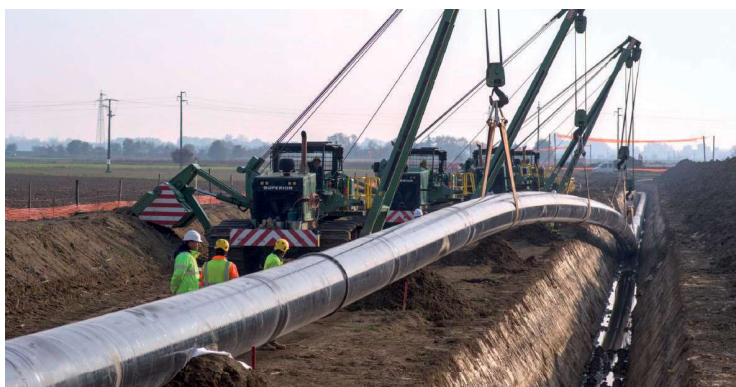
La posa dei tubi nel cantiere del rigassificatore FOTO MASSIMO FIORENTINI
