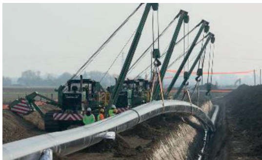
Dei 32 chilometri di lavori a terra ne sono già stati realizzati il 24-25%
