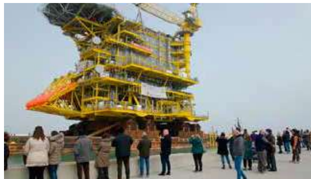
Un impianto dell'azienda di via Trieste
