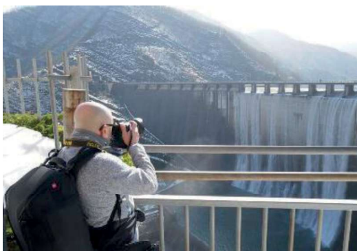
Panoramica della diga. In alto, Tonino Bernabè, presidente di Romagna Acque
