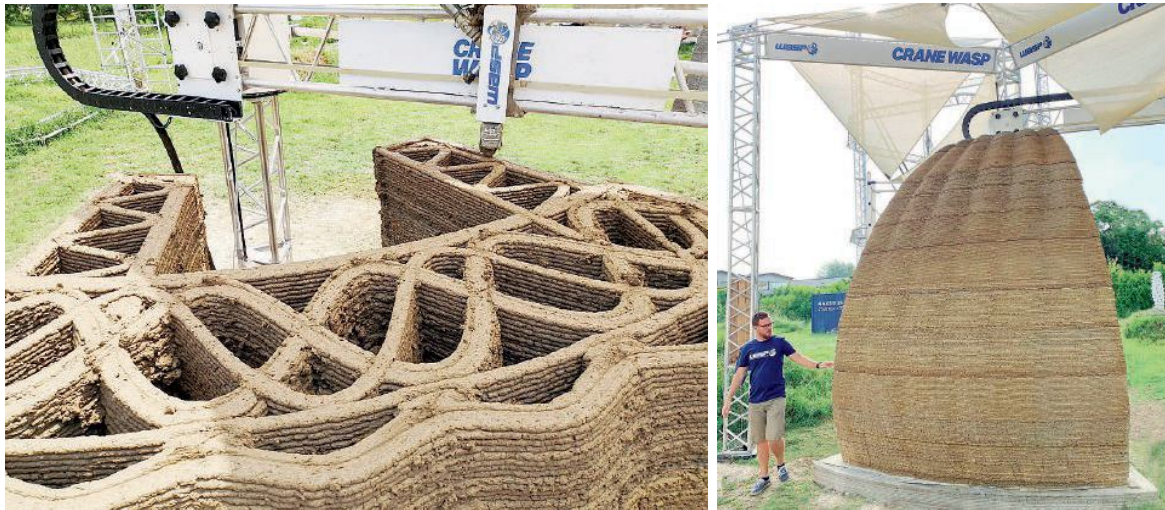
Una sezione dell'habitat ecologico concepito come un alveare e a destra un particolare di un'abitazione creata con la stampante in 3D
