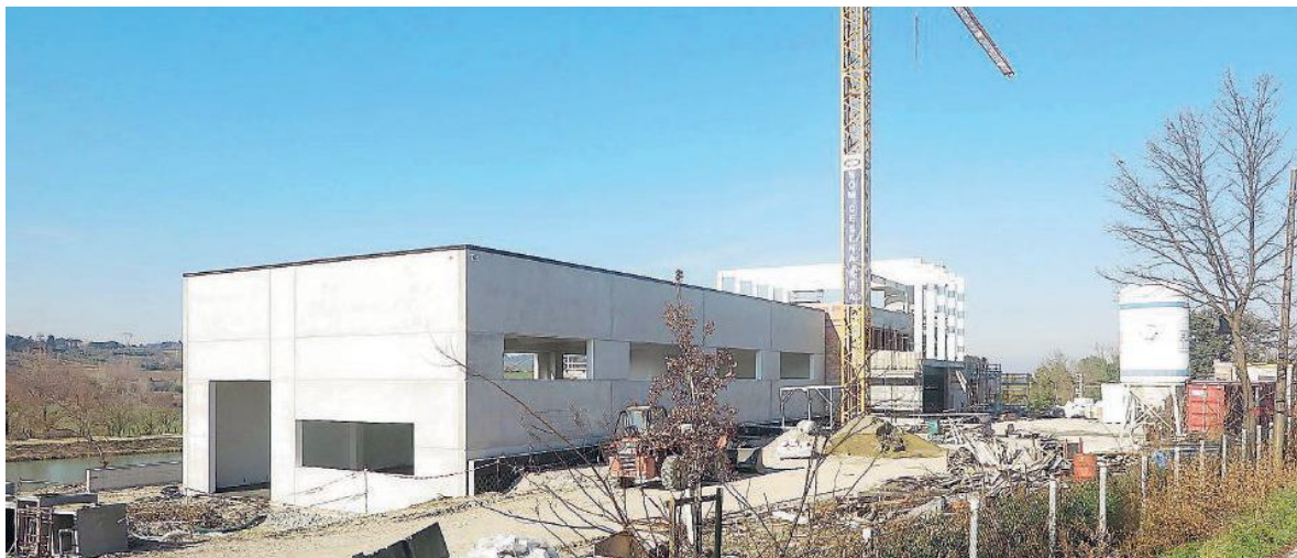
Il cantiere della birreria che nascerà al posto del Velvet
