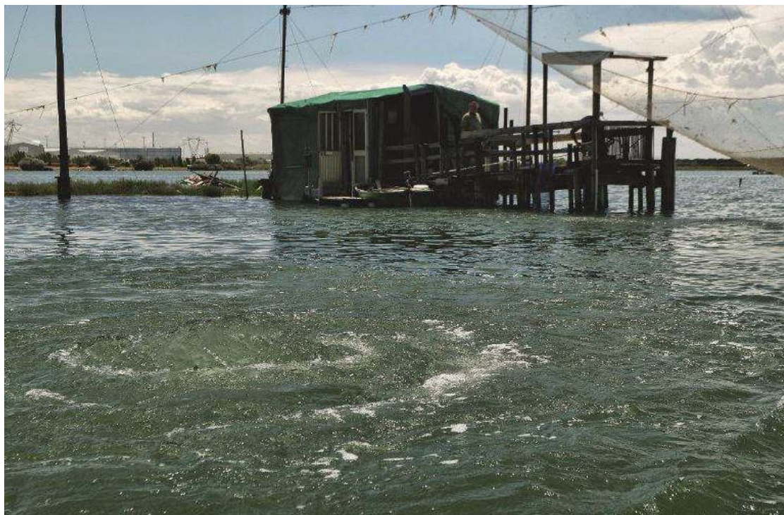
Il fiotto di acqua che fuoriesce dalla condotta rotta nella pialassa Baiona. FOTO MASSIMO FIORENTINI
