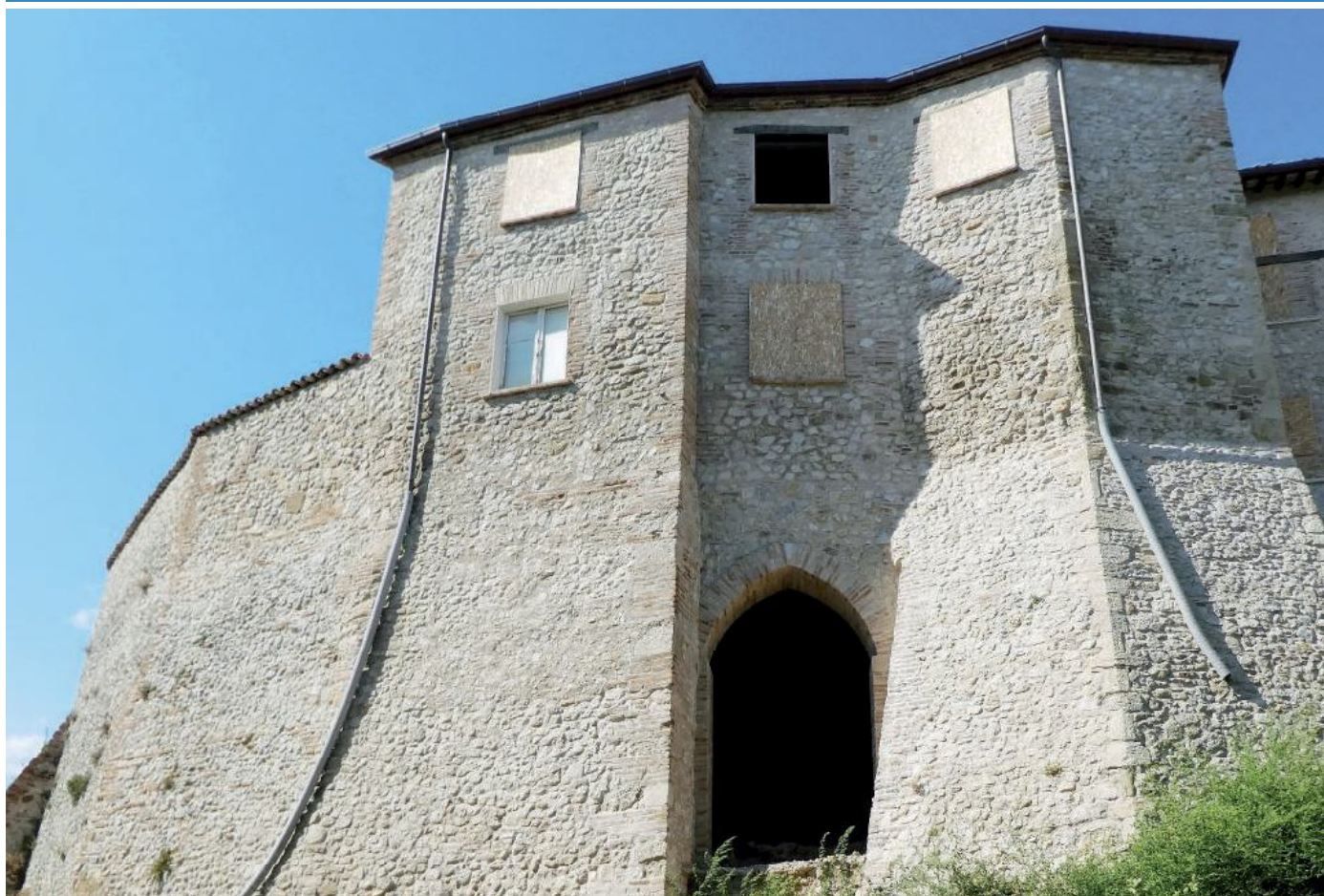
In alto una delle porte di ingresso alla Rocca di Passerella dove sorgerà la struttura alberghiera di lusso, accanto la vista dall'alto di Verucchio e il chiostro interno della Rocca
