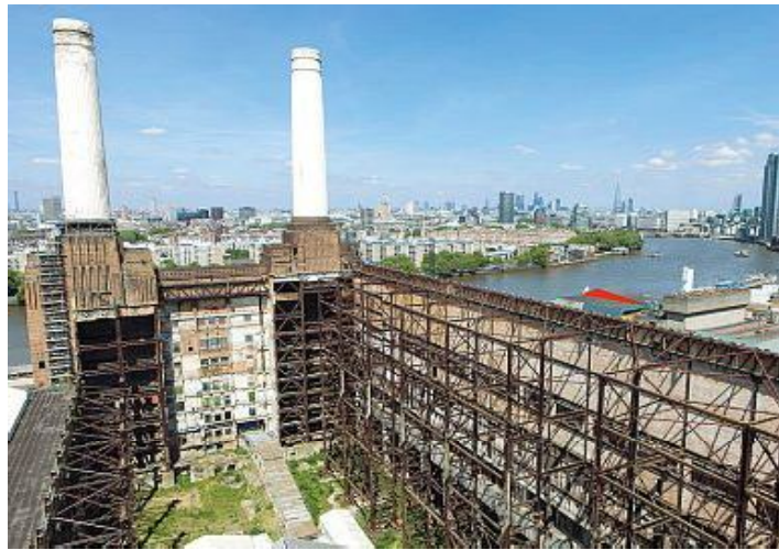
Sul Tamigi I lavori di recupero iniziati alla ex centrale termoelettrica di Battersea
