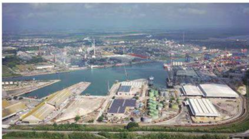
Una veduta dall'alto del porto intermodale di Ravenna
